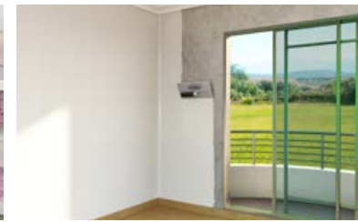
NIVELACIÓN Y ACABADO DE MUROS INTERIORES
