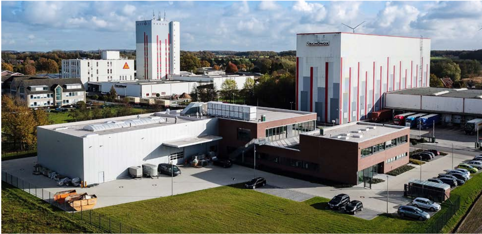
La planta de última generación en Rosendahl, Alemania, con el nuevo Centro de Tecnología para Clientes
