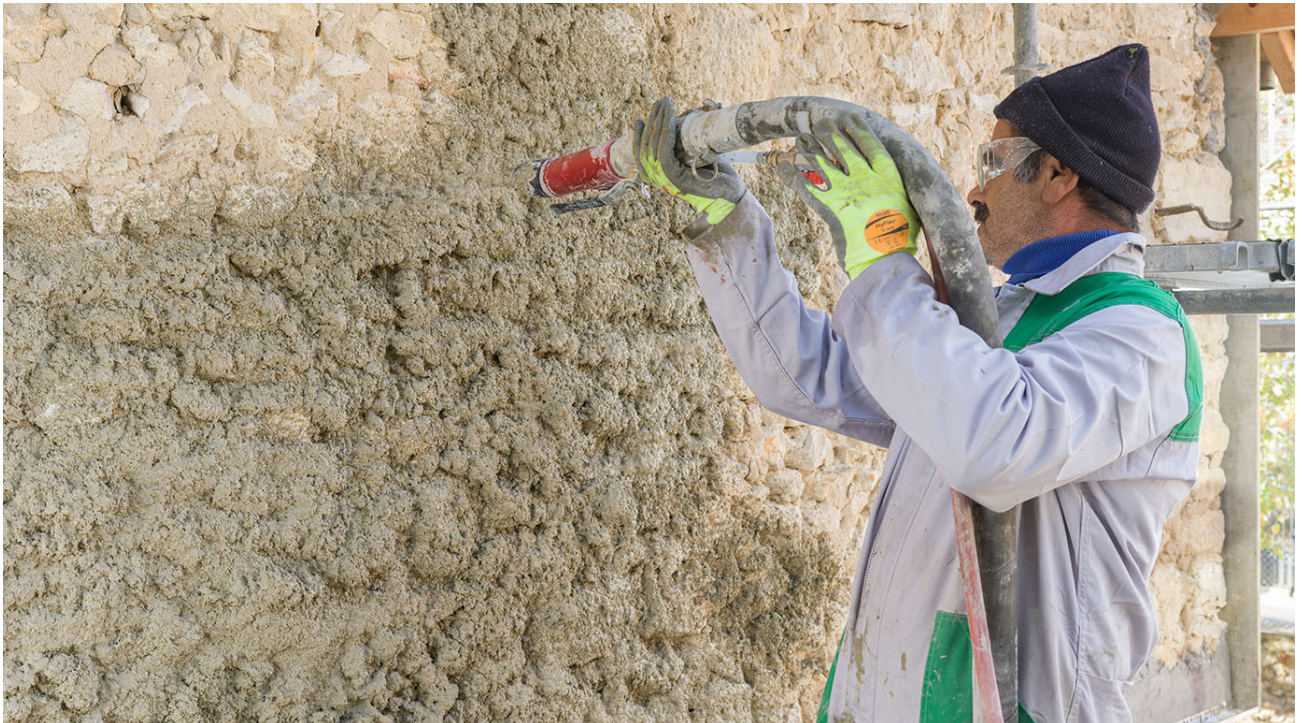
PARNATUR®, a primeira argamassa de isolamento térmico e acústico fácil de aplicar à base de cânhamo
