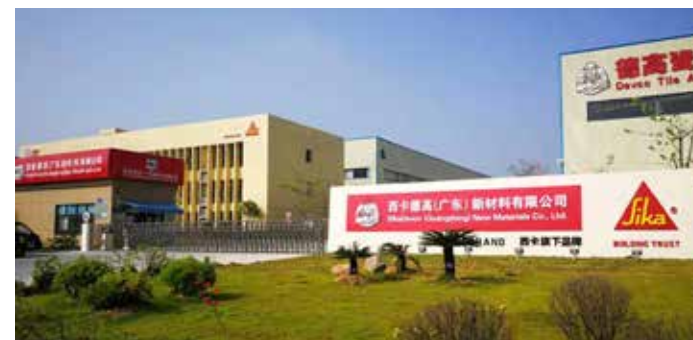
Usine Davco à Guangzhou, en Chine
