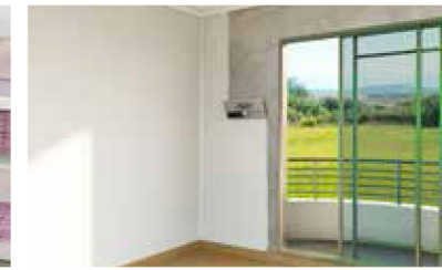
NIVELAMENTO E ACABAMENTO DE PAREDES INTERNAS
