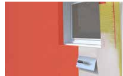
室外墙面找平和美化装修
