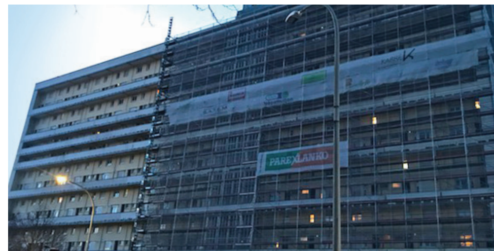
Site de travaux « Le Moustoir », France.
